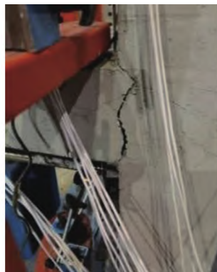
(b) 试件 2 节点区混凝土脱落
